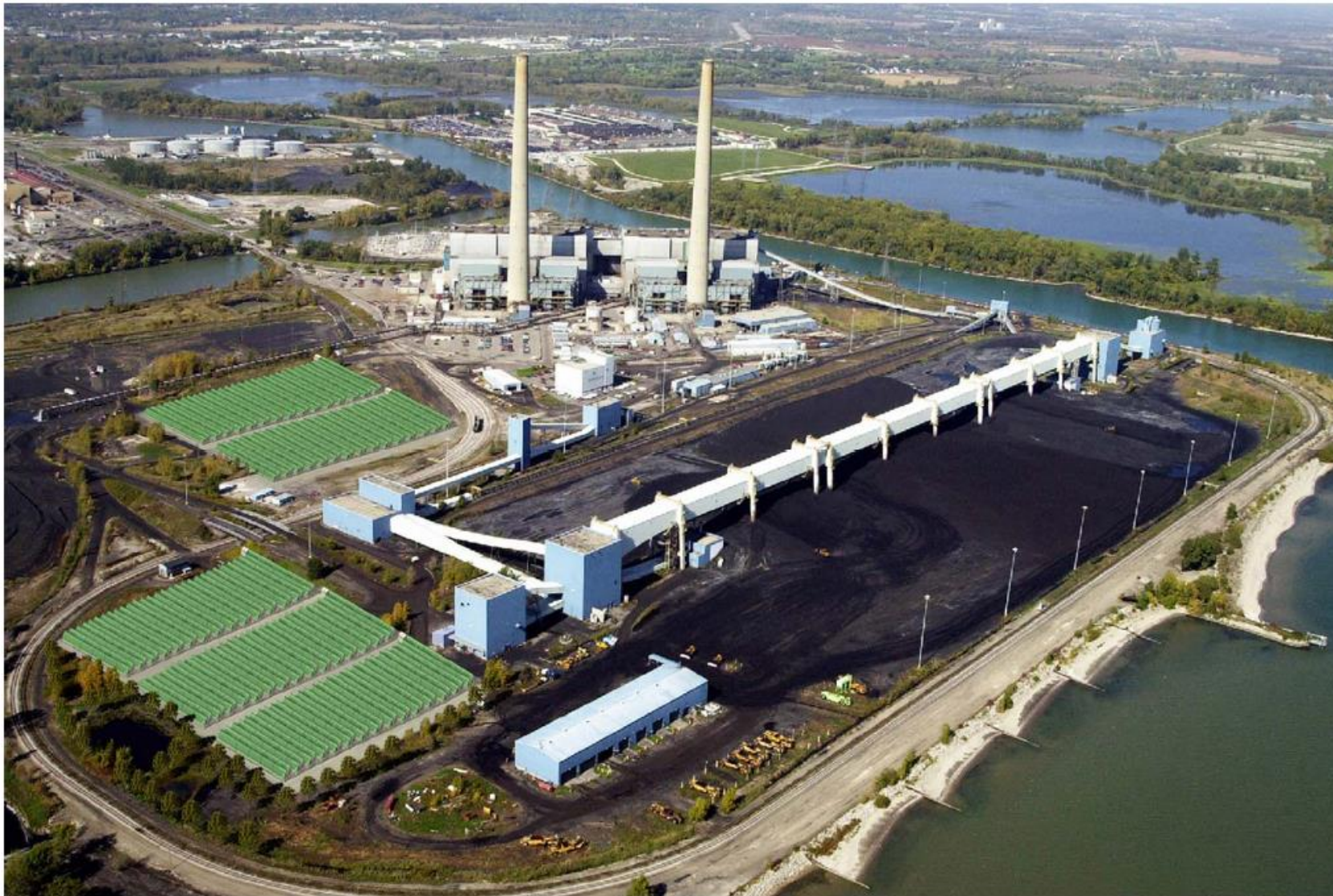
Vue aérienne de la centrale de cogénération du MIT couplée aux bioréacteurs à microalgues de GreenFuel Corporation (en vert sur la photo)
