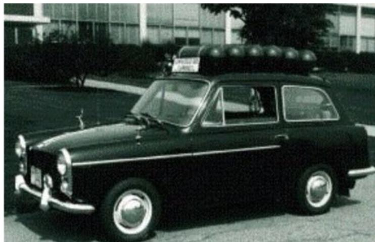
Prototype de 1970 d'une Austin A-40, pile à combustible de 6 kW, réservoir d'hydrogène sous pression, placé sur le toit et contenant 2kg d'hydrogène. Elle a parcouru près de 16 000 km pendant les 3 années qu'a duré cette expérimentation. Mais la technologie alcaline était trop sensible au CO2..
