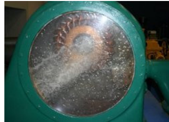
[ Turbine Pelton de l'ENSEM ]
