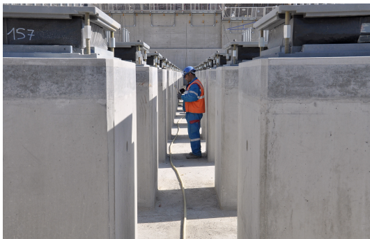
Construction ITER / Plots parasismiques / Février 2012 / Iter.org
