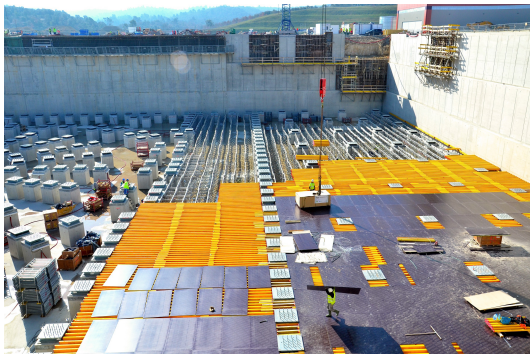
Construction ITER / Avril 2013 / Iter.org
