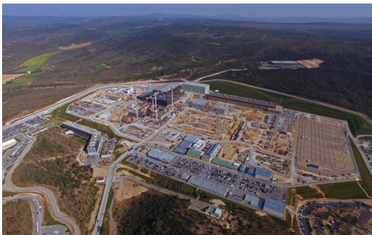
Chantier ITER / Avril 2017 / Iter.org
