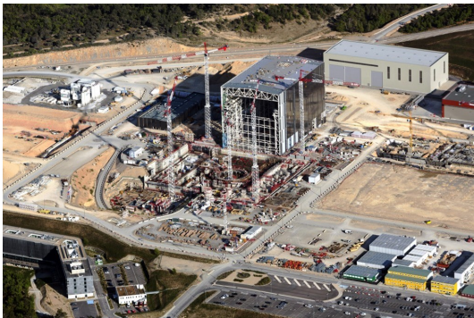
Construction ITER / Avril 2016 / Iter.org
