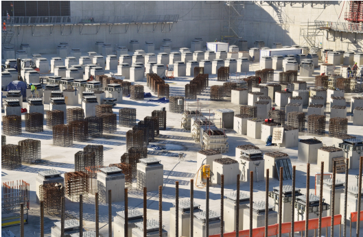
Construction ITER / Janvier 2012 / Iter.org
