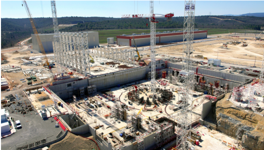
Construction ITER / Avril 2015 / Iter.org
