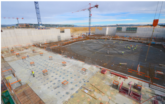
Construction ITER / Avril 2014 / Iter.org
