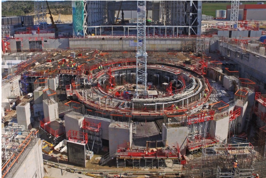
Construction ITER / Avril 2016 / Iter.org
