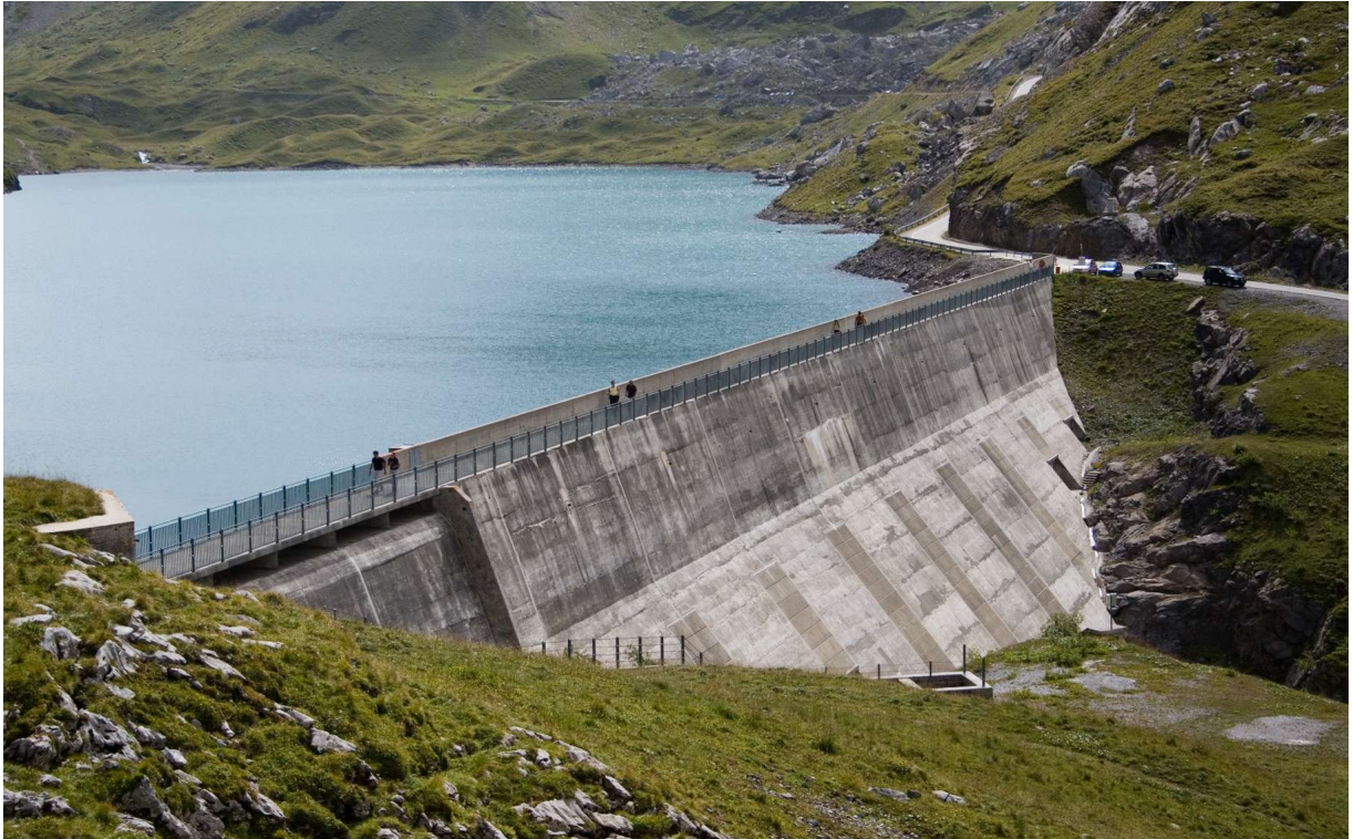
FIGURE 4 – Photographie d'un barrage poids
