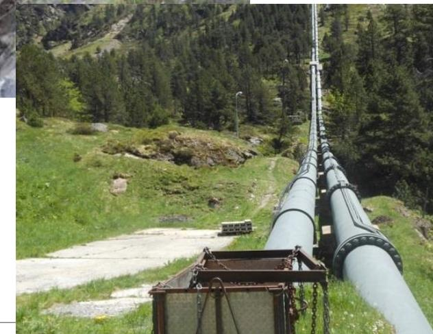
La détermination du diamètre est l'objet d'un optimum économique
