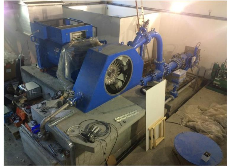
Pelton axe horizontale et alternateur 3 MVA
